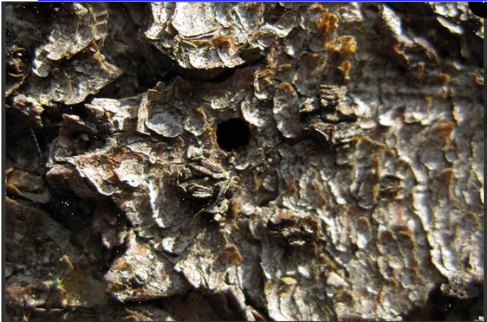
Abb. 12: Bohrloch (Foto: C. Triebenbacher)
